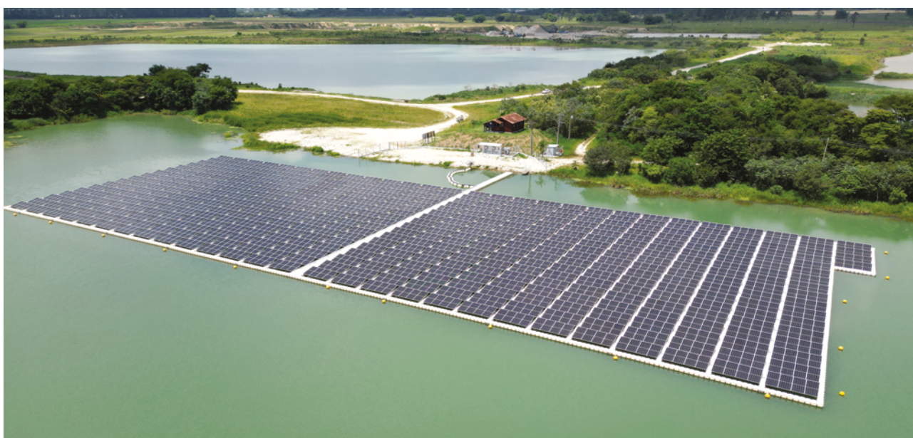
Foto 4 – Implantação finalizada da Usina Solar Flutuante. Fonte: Grupo AB Areias.
