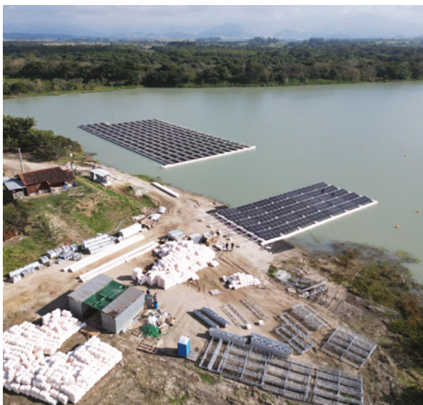
Fotos 2 e 3 – Sequência da montagem da Usina Solar Flutuante. Fonte: Coelte, F2B e grupo AB areias.
