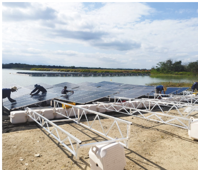
Fotos 2 e 3 – Sequência da montagem da Usina Solar Flutuante. Fonte: Coelte, F2B e grupo AB areias.
